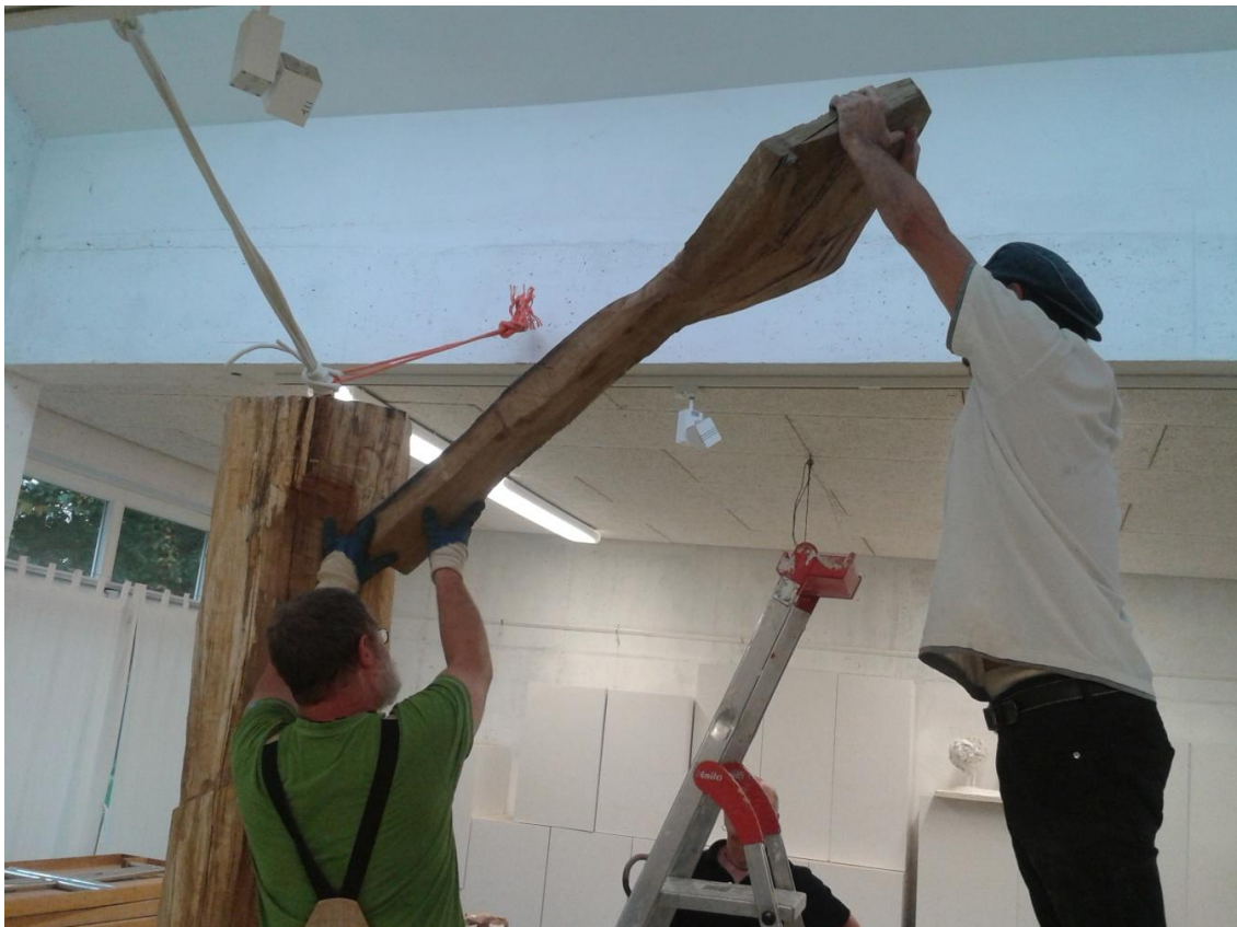
- Probemontage des ersten Blattes -
