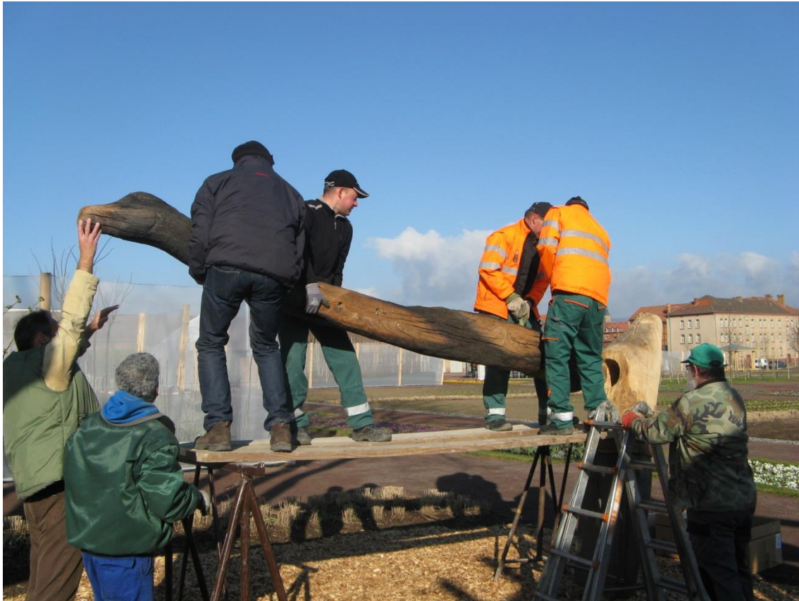
Der Bautrup bei der Arbeit
